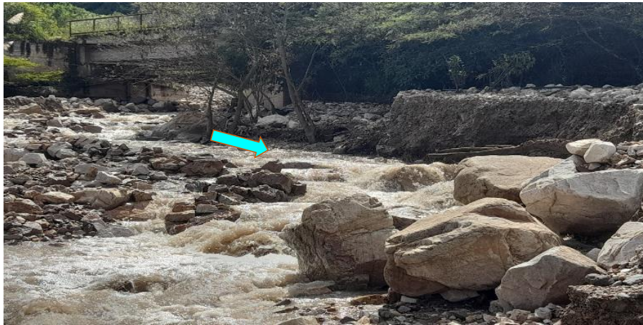
FIGURA N°01: TRAMO CRÍTICO DEL RIO NARANJOPAMPA SECTOR CAS. NARANJOPAMPA SE APRECIA LA EROSION DE LA MARGEN DERECHA DEL RIO QUE REQUIERE DIQUE CON ENROCADO
